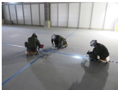
目地充填状況
