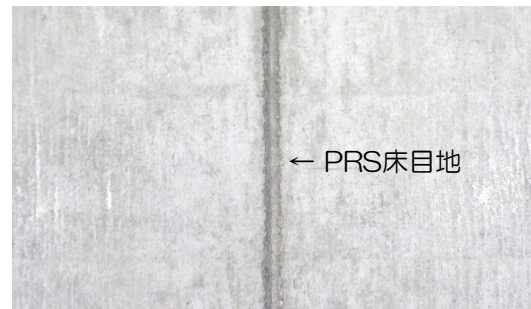
竣工後3年目の状態
