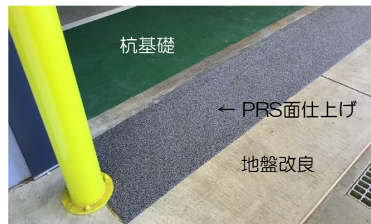
床段差15mmの解消例
