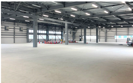
打設後の状況
