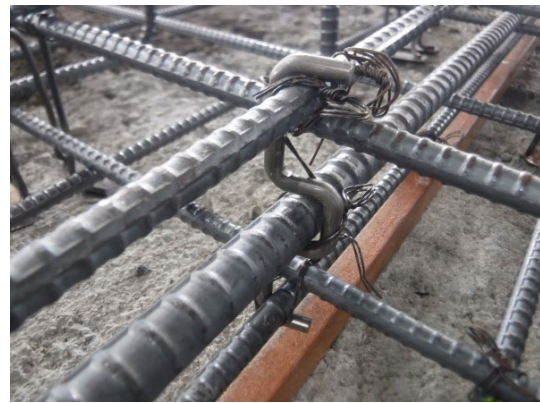
専用ジグによる誘発材の固定状況
