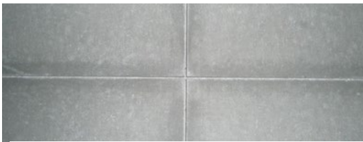
カッター目地の設置状況
