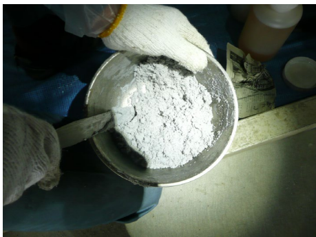
写真3 材料混合状況
