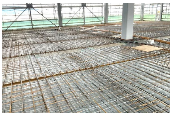
写真1 スラブ配筋状況（S造架構例）
