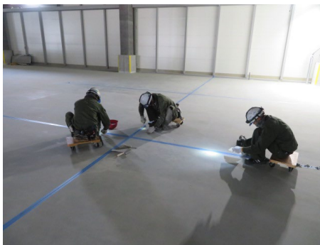
写真4 目地充填状況
