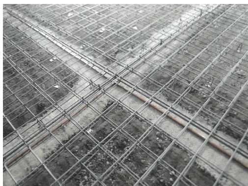
写 1.1 ひび割れ誘発材の設置状況例
