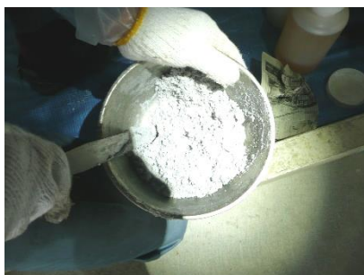
材料混合状況
