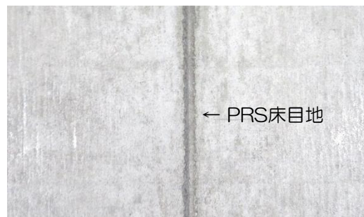
竣工後3年目の状態
