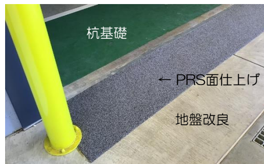
床段差15mmの解消例
