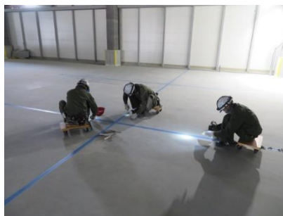
目地充填状況
