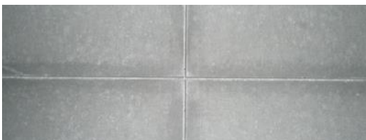
カッター目地の設置状況
