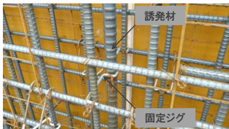
誘発材の固定状況
