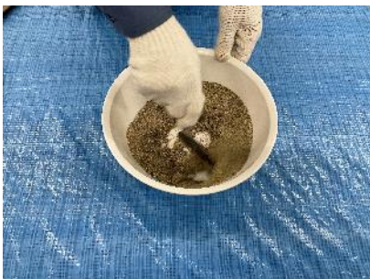
材料混合状況
