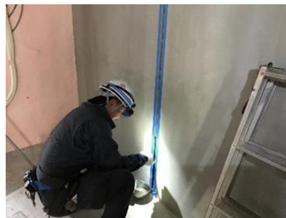
目地充填状況
