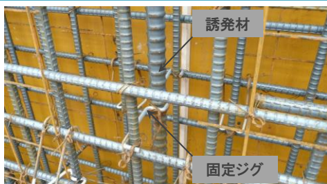
誘発材の固定状況
