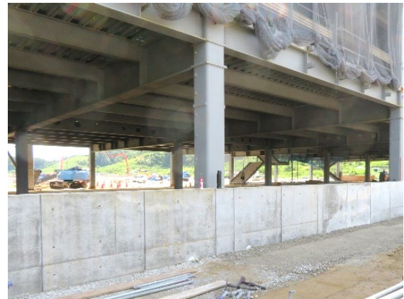
脱型後の状態 (目地柱際+@1500mm)
