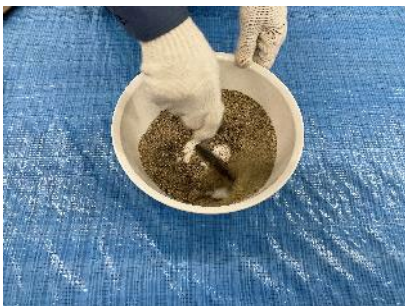
材料混合状況
