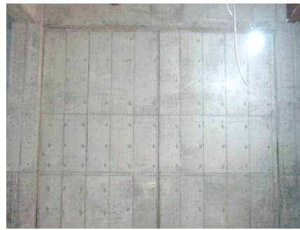
壁の仕上がり状態
