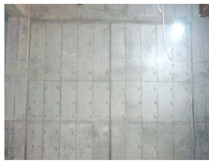
耐力壁の仕上がり状態
